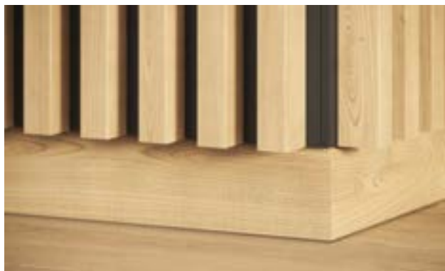
ukázka ukončení dekoračního panelu nad podlahovou lištou
